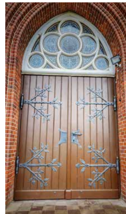
Iepriekš restaurētās durvis jau rotā baznīcu. Vīļakas baznīcas centrālo ieejas durvju restaurācijai Nākotnes Atbalsta fonds piešķirjis 2900 eiro.
